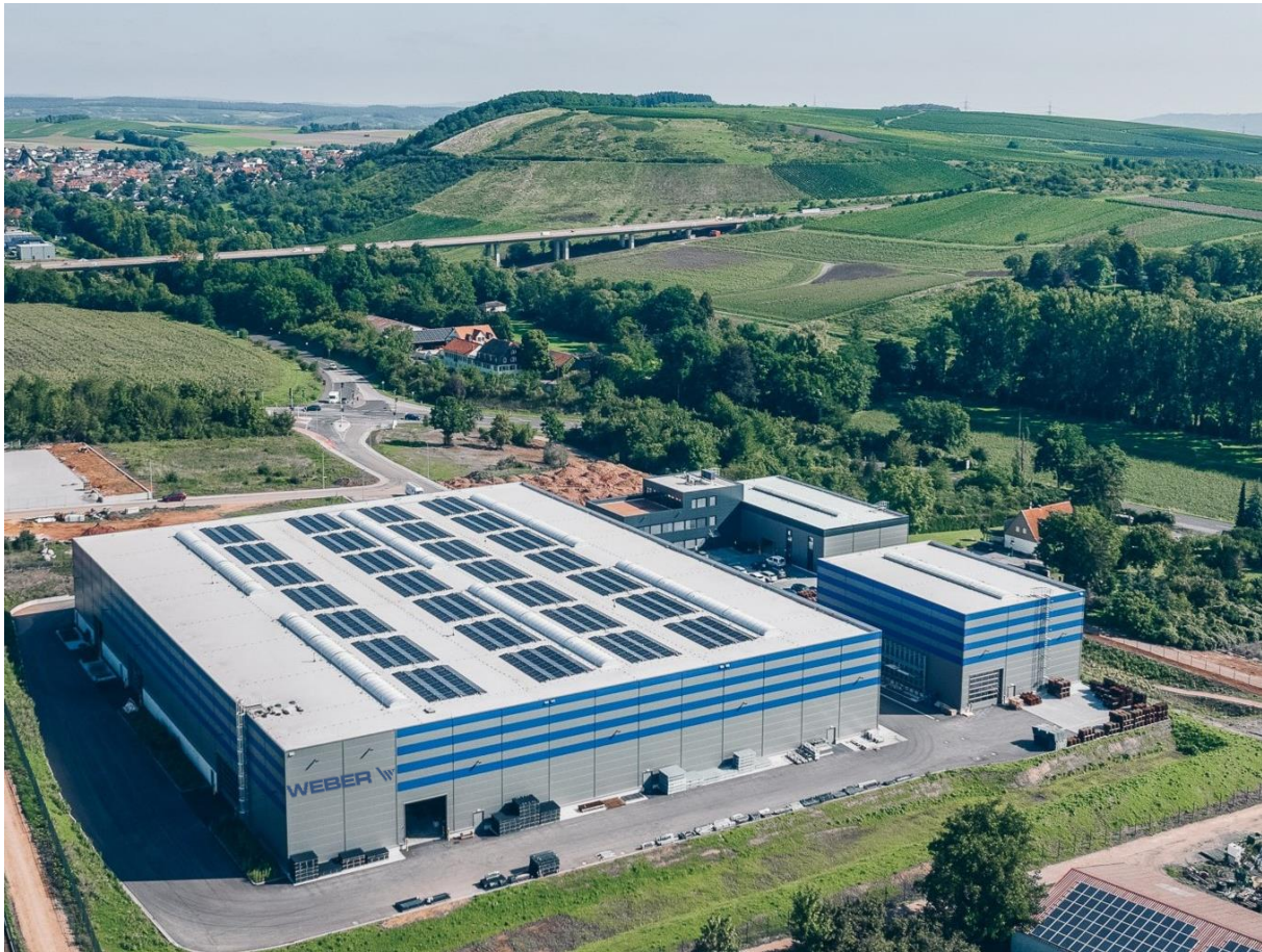
Abb. 1 Unser Neubau mit 400 kWp-PV-Anlage & Ausstellung: C.A. Weber GmbH – Carl-August-Weber-Str. 3 – 55593 Rüdesheim
